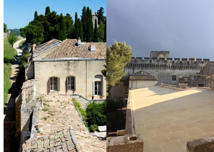
Le toit couvert de tuiles avant les travaux. Le nouveau dallage et les gargouilles.
